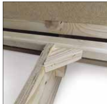
Rinforzi angolari Angle reinforcements
