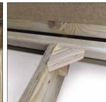
Rinforzi angolari Angle reinforcements
